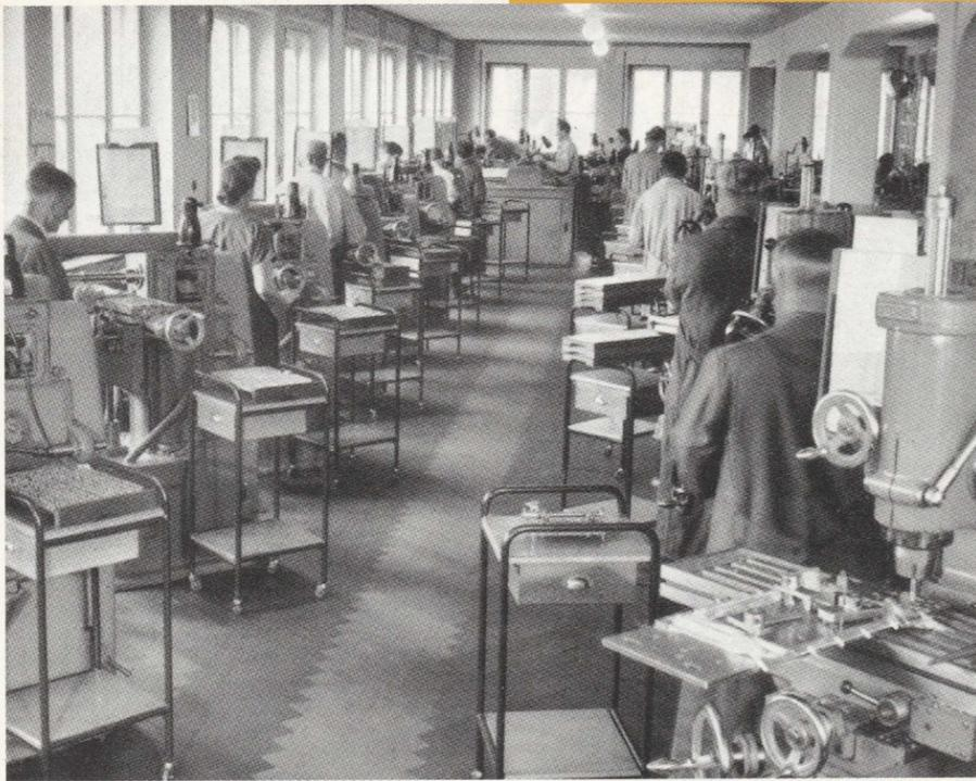
Horizontal- und Vertikal-Fräsmaschinen
